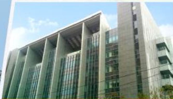
中華電信板橋資料中心 Chungghwa Telecom
